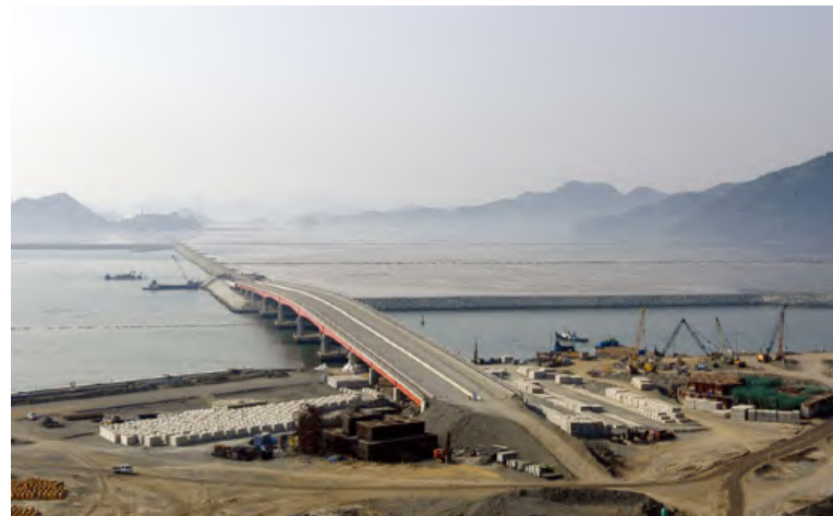
부산 신항 준설토 투기장 호안 축조공사(2공구)
